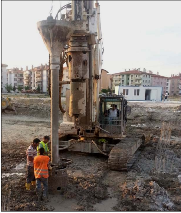
Şekil 5..Fore kazık beton dökümü
