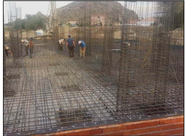
Şekil 6. Kazıklı radye temeli hazırlanışı
